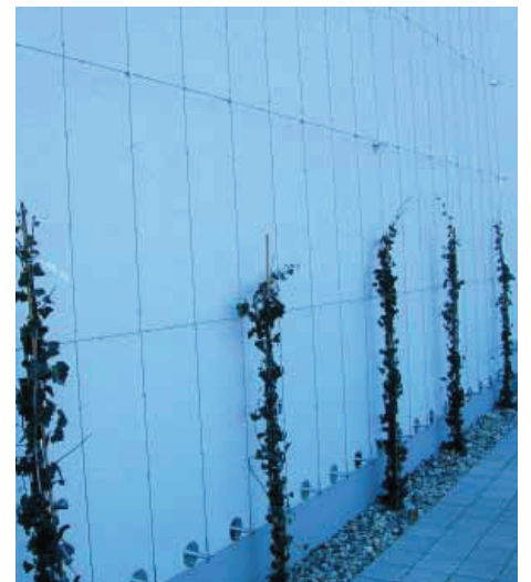
Hedera helix benötigt, wie alle anderen Haftwurzelkletterer auch, keine Kletterhilfen! Kletterhilfen und Kletterpflanzen sollten bei einer guten Planung zusammenpassen.
