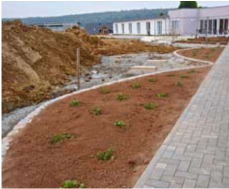
Der Bau: Beet mit 20 cm reinem Sand abgedeckt, Initialpflanzung im Herbst 2013
