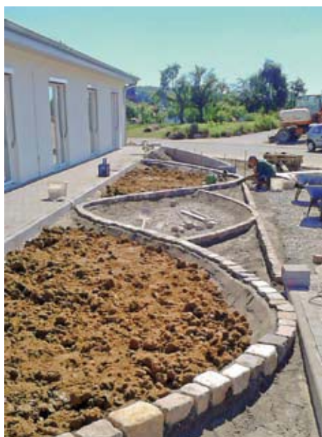
Vorbereitung Sandbeet: Verfüllen mit Rohboden
