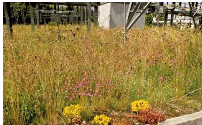
Blumen-Schotter-Rasen im Umspannwerk Passau
