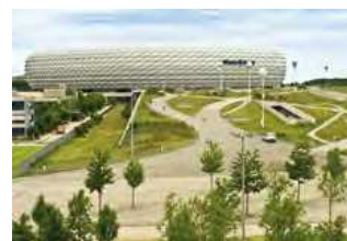
Dachbegrünung des Parkdecks der Allianzarena in München im Jahr von Ansaat und Pflanzung (Foto: Rieger-Hofmann GmbH)
