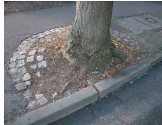
In der Praxis häufig zu sehen: versiegelter und viel zu kleiner Wurzelraum für Straßenbäume.
